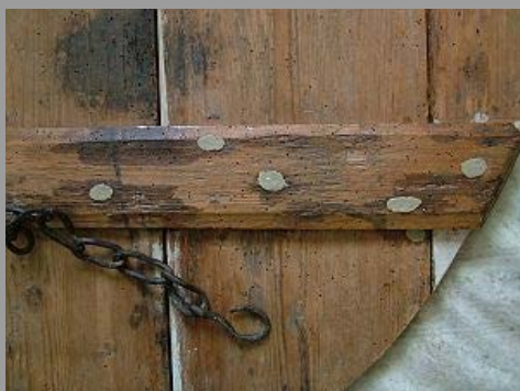
28. fotó. Kiegészítés közben
