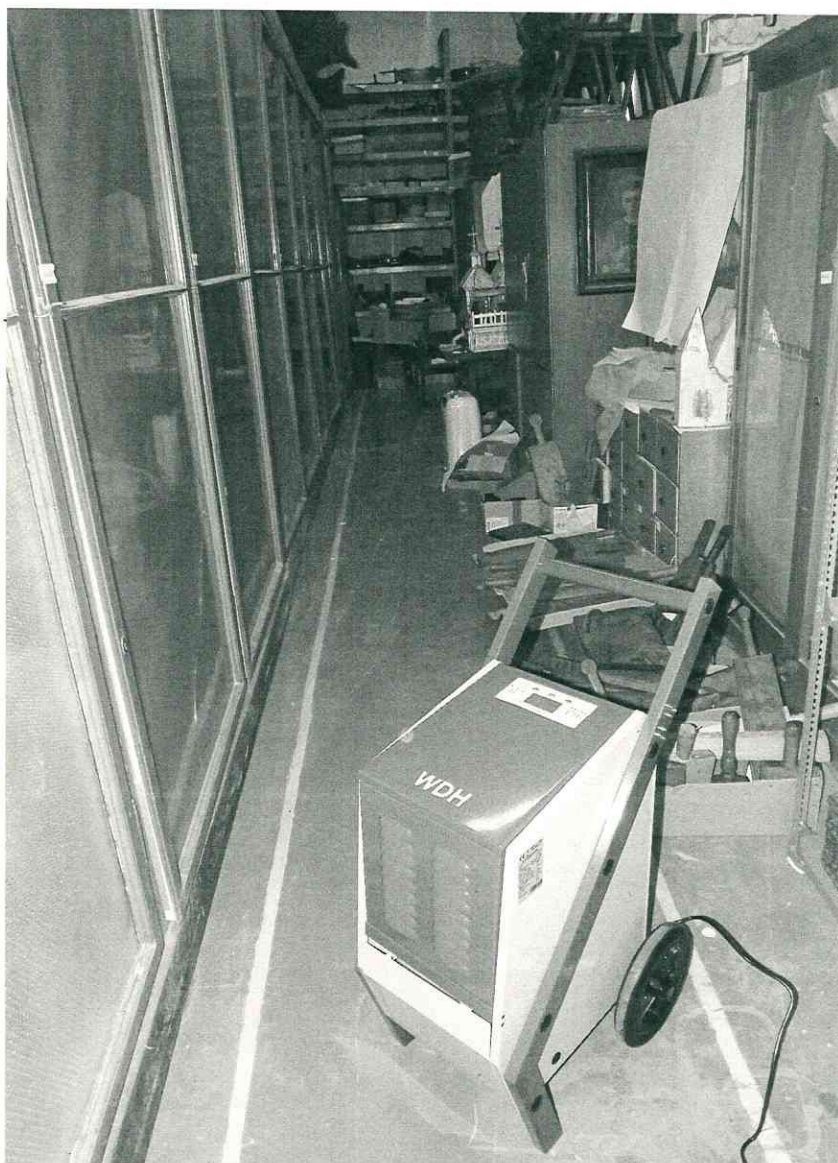
A néprajzi gyűjteményben beüzemelt WDH 500 AH - páramentesítő
